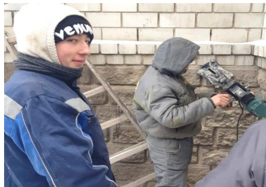
Фото 2. Монтаж ввода газопровода
