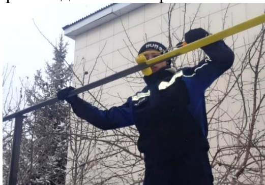
Фото 1. Окраска наружного газопровода
